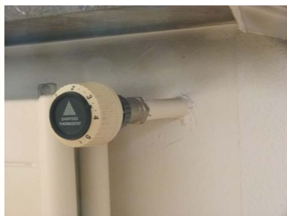
Rohre in der Aussenmauer eingelassen
