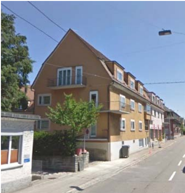
Das Mehrfamilienhaus mit der Pilotanlage
